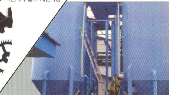
△ 상향류 모래여과기 개선작업
