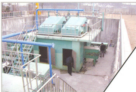
△ 제진기기 설비 개선작업
